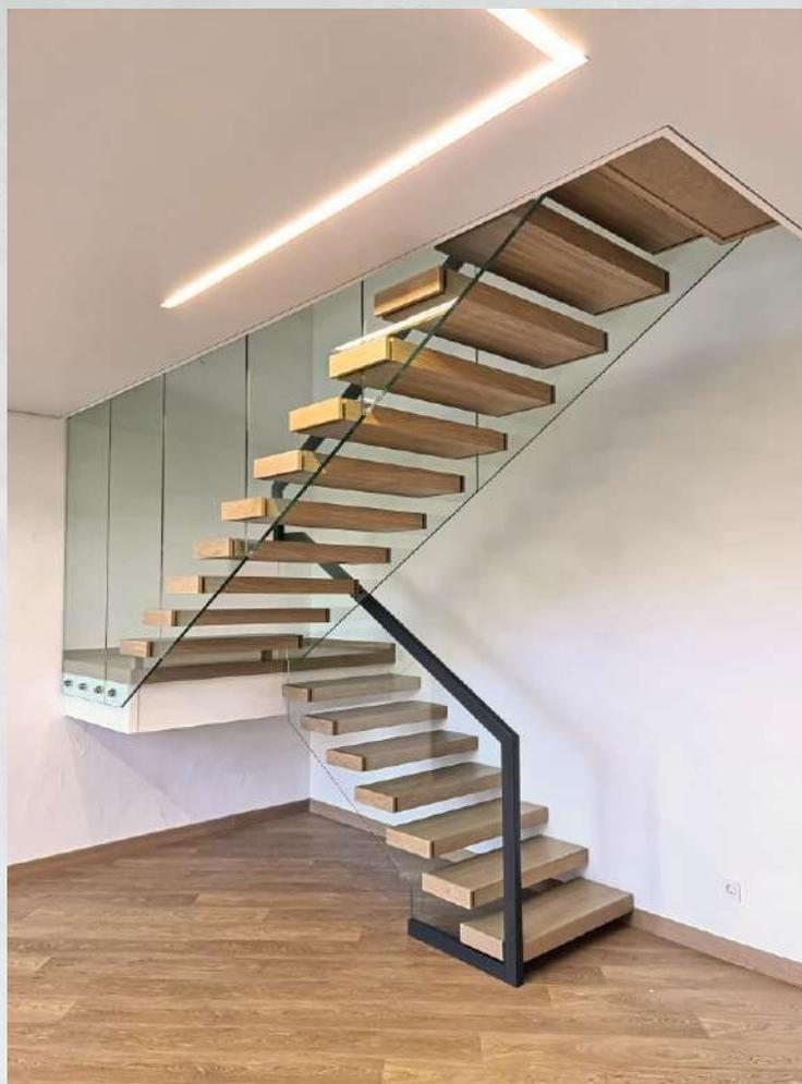
**КОНСОЛЬНЫЕ ЛЕСТНИЦЫ** – представляют собой бескаркасные системы, которые не имеют каркасов, опор или оснований. В роли каркаса выступает стена и меж-этажные перекрытия. Внешне такая лестница как будто бы парит в воздухе, отсюда она получила название парящей. Мы готовы предложить решения любой сложности и по лучшей цене!
